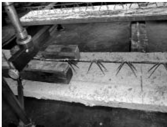
Obr. 14. Počátek vybočení diagonál nad vnitřní podporou
