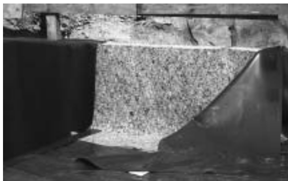
Obr. 1. Výstavba vodorovného dynamického filtru v základové spáře budovy v Praze 9
