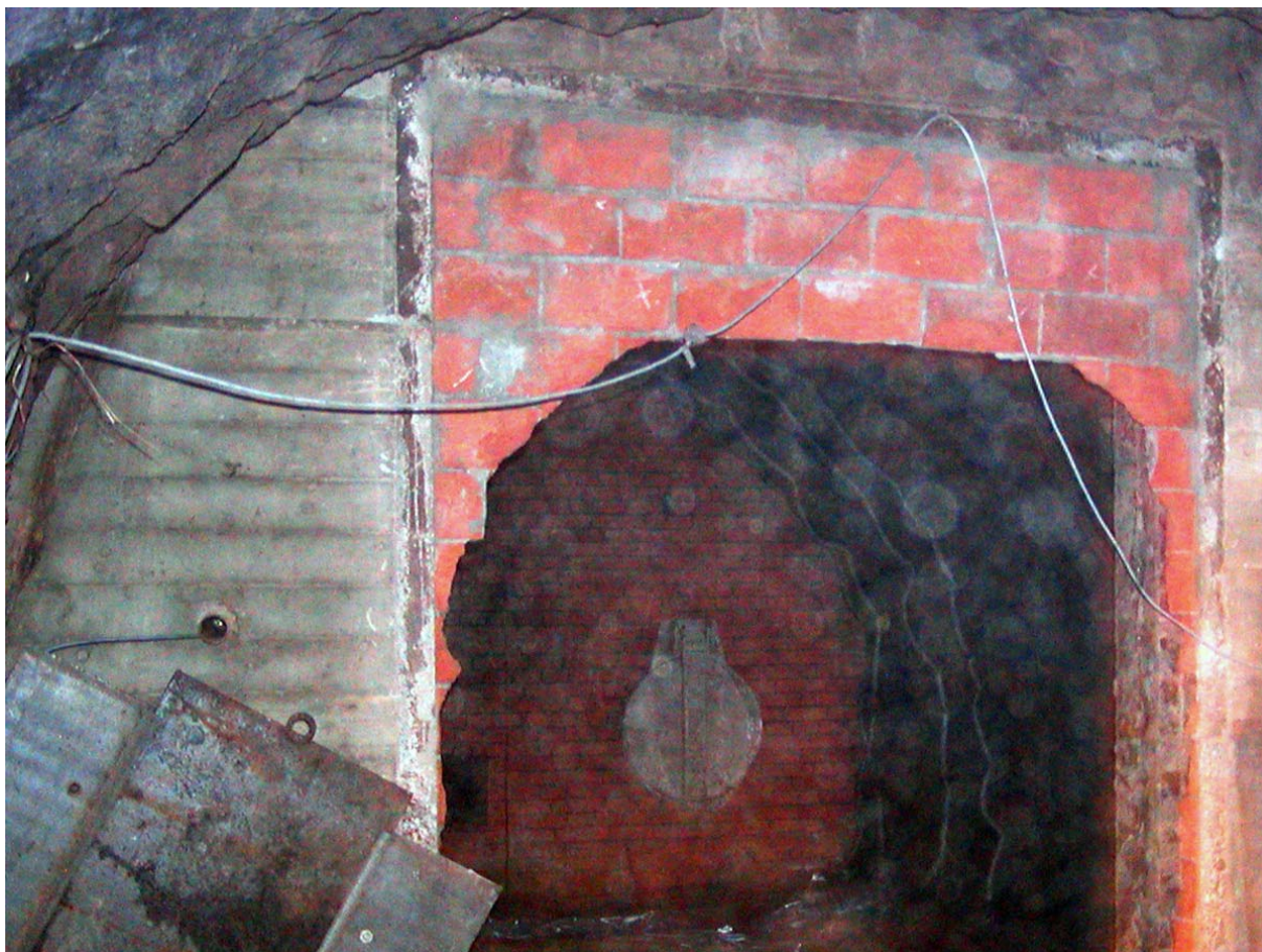
Obr.7 Fotografie zděných příček v přehradní konstrukci c) havarovaná zeď o tloušťce 65 mm v přehradní stěně
