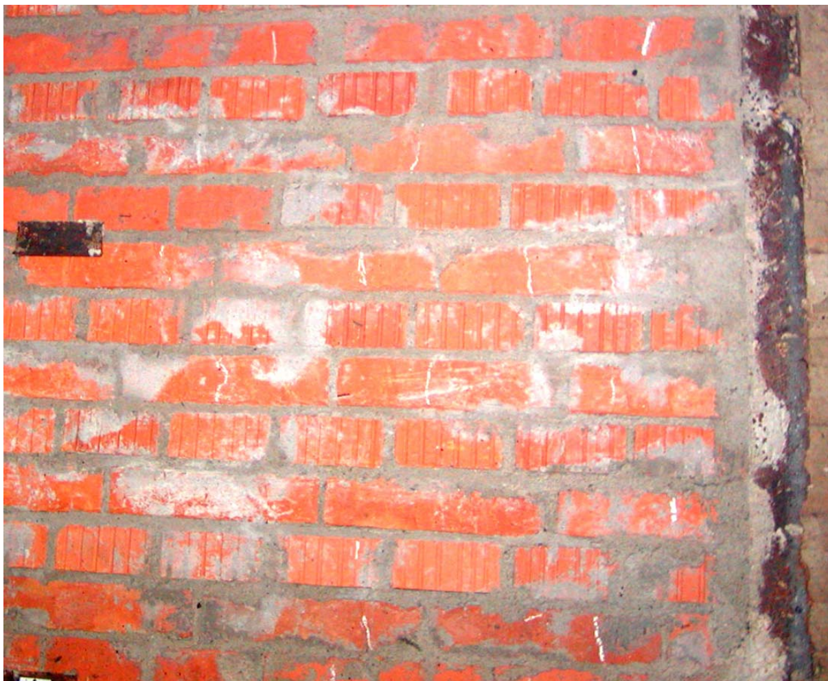
Obr.7 Fotografie zděných příček v přehradní konstrukci b) část zdi o tloušťce 290 mm se zvýrazněnými trhlinami ve zdivu
